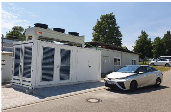
Рис. 5. Металлогидридный термосорбционный компрессор (30–450 бар, 22.5 м 3 /ч) в составе водородной заправочной станции, разработанный в рамках проекта ЕС «COSMHYC»
