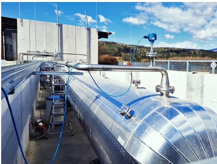
Рис. 2. Металлогидридные аккумуляторы водорода емкостью до 250 кг H_2 производства компании GKN Hydrogen (Германия)
